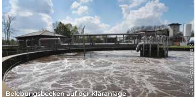
Belebungsbecken auf der Kläranlage
